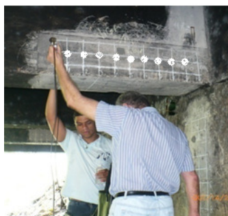
Figura 1: Desenho da malha em longarina de ponte para medidas com ultrassom e esclerômetro.
